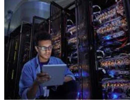
SOPORTE A INFRAESTRUCTURA DEL CENTRO DE DATOS y LEASING
